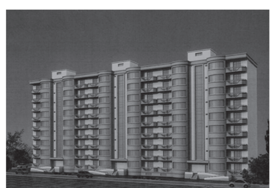
9-ти этажное жилое здание с 81 квартирами для инвалидов и семей Шехидов Карабахской войны (2008-2009)
