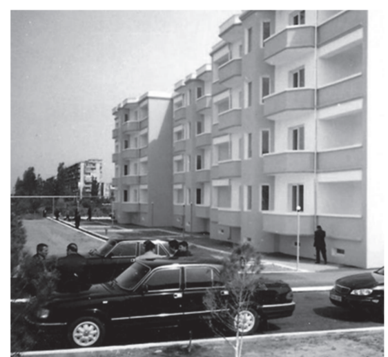
Построенный 3-х блочный, 4-х этажный жилой дом для инвалидов и семей шехидов Карабахской войны в посёлке Хырдалан (2003-2004)
