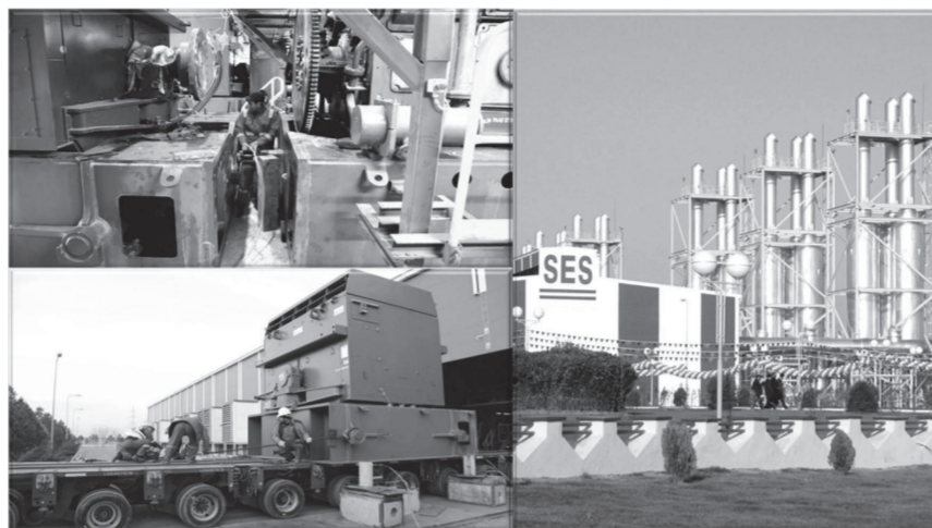
addım atılmış olacaq. “Azərnerji” ASC “Reabilitasiya Proqramı” çərçivəsində Cənubi Qafqazın ən böyük istilik elektrik stansiyası olan
